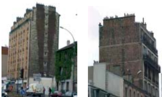
Figure 5.7 : conduits de fumée individuels
